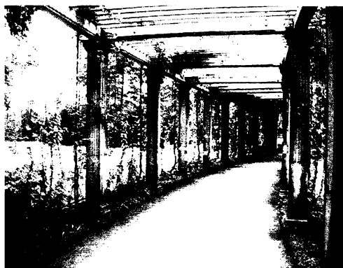
Рис. 2.5.15. Пример устройства пергол. Столбы выполнены из камня, перекладины деревянные (Екатерининский парк, Царское село)
