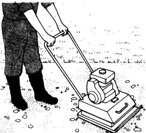
6 Заполните пустоты плотным материалом и утрамбуйте его садовым катком или механизированным вибратором. Насыпьте сверху слой песка и также уплотните его.
