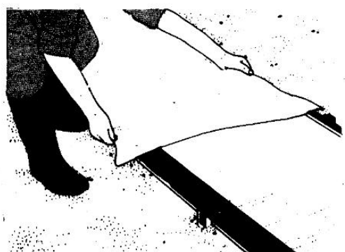
4 Накройте плиту плотным полиэтиленом и оставьте ее для затвердевания на четыре дня.
