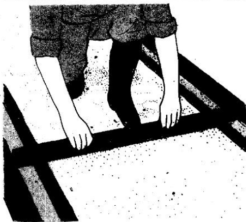
8 Засыпьте песком подготовленное основание, на которое вы сможете укладывать плиты, кирпичи или блоки уже непосредственно. Для удобства укладки разделите поверхность двора на секторы.
